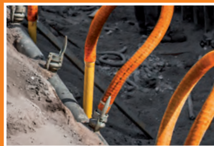
Einspülen von Filtern
