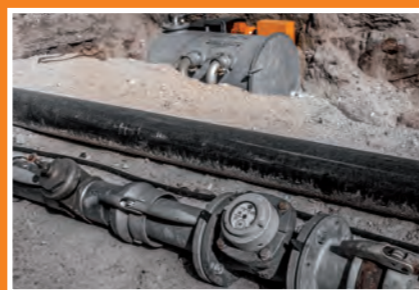
Füllen von Rohrleitungen
