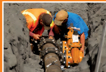
Wasserversorgung beim Bau
